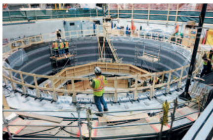
□ Montagem do Estator
