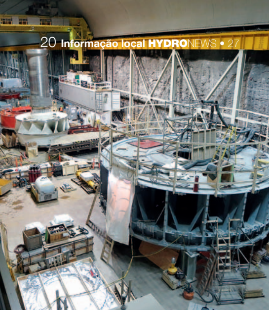
□ Casa de Força
