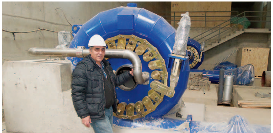
▣ Representante do cliente na frente de uma turbina Francis ANDRITZ HYDRO COMPACT
