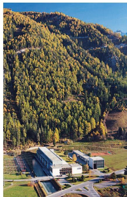
▣ Casa da força e comutadores
