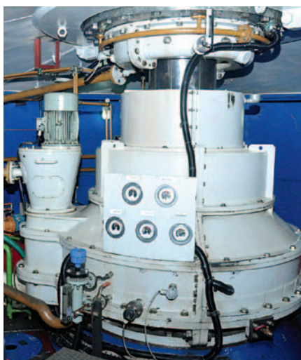
▣ Fosso da turbina após a reforma
