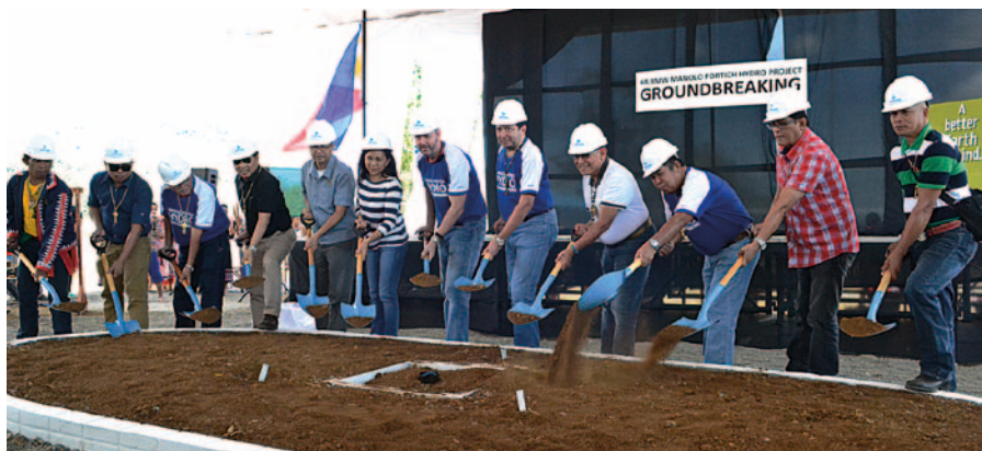
▲ Inicio de obras en la CH Manolo Fortich
