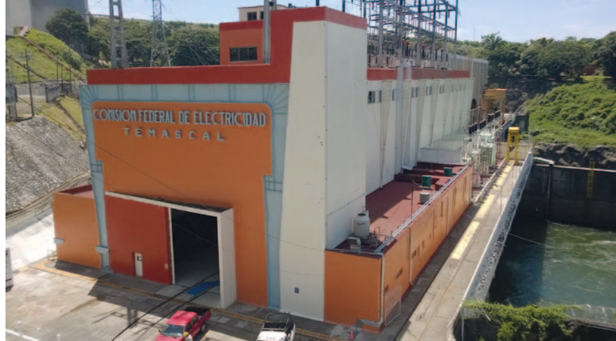
▲ Casa de máquinas
