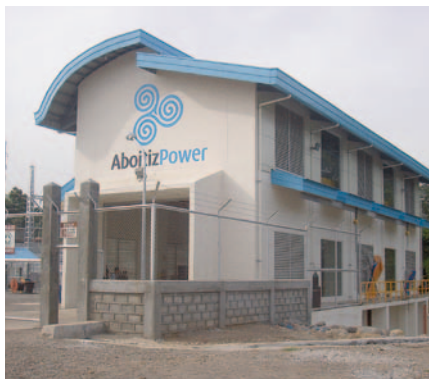
▼ Casa de máquinas de la CH Tudaya 2
