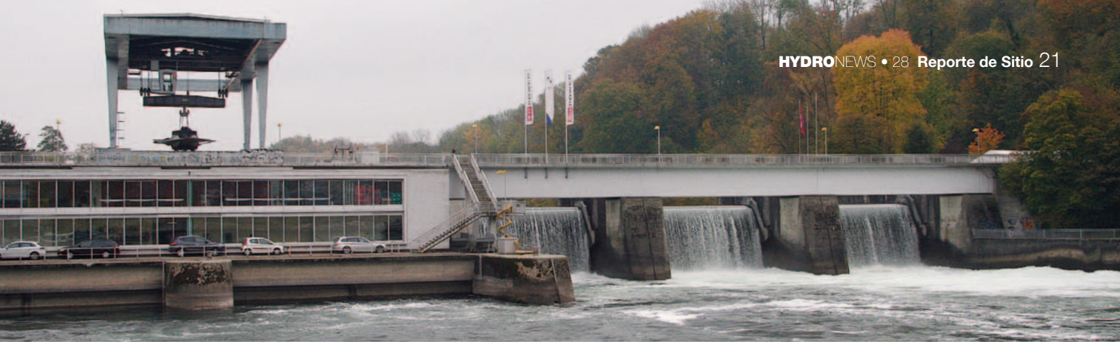
▲ Central hidroeléctrica en el Río Rhine
