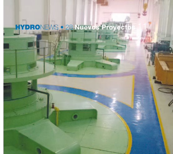
▲ Unidades #1 – #4 antes de la rehabilitación
