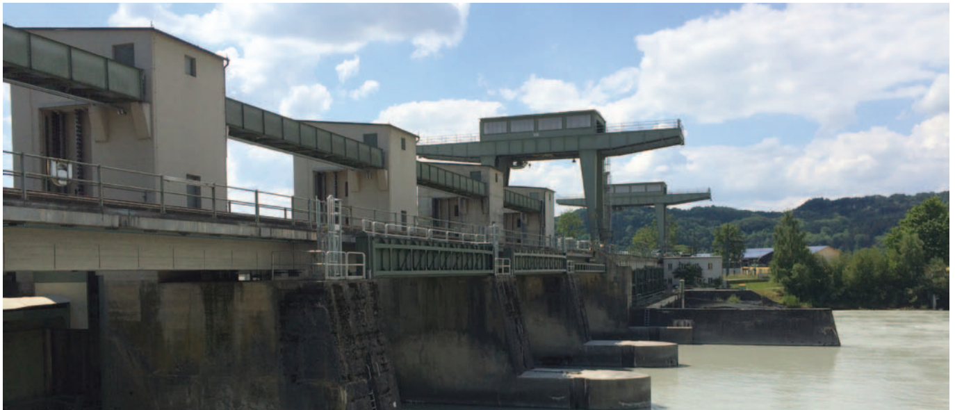
▲ Central hidroeléctrica Gars
