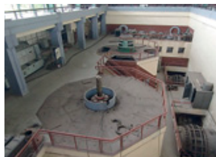
▲ ГЭС «Djoué» перед реконструкцией
