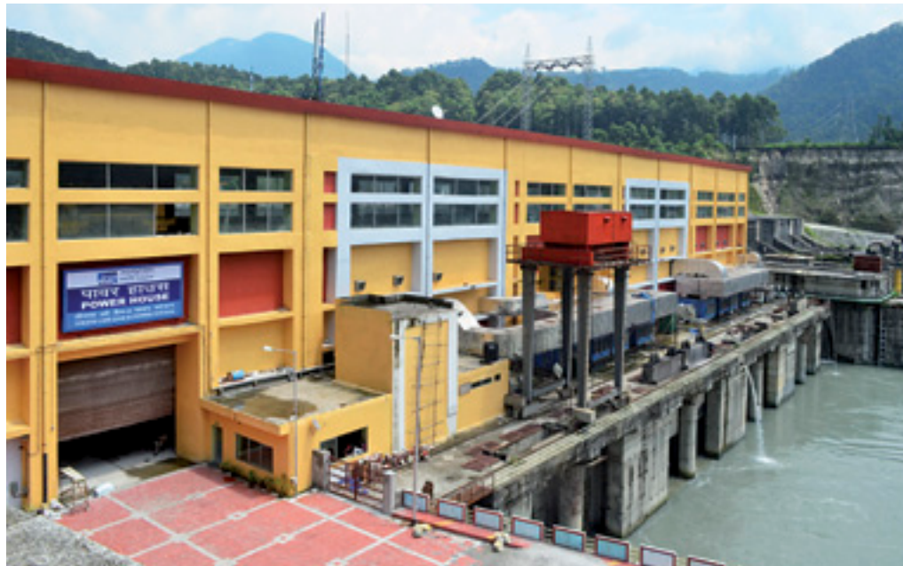
▲ Здание ГЭС «Teesta Low Dam III»
