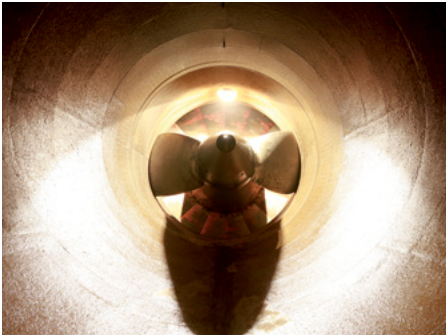
▲ Ввод в эксплуатацию первого двухлопастного рабочего колеса
