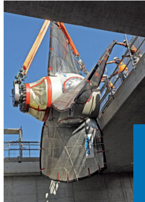
▲ Монтаж рабочего колеса гидротурбины
