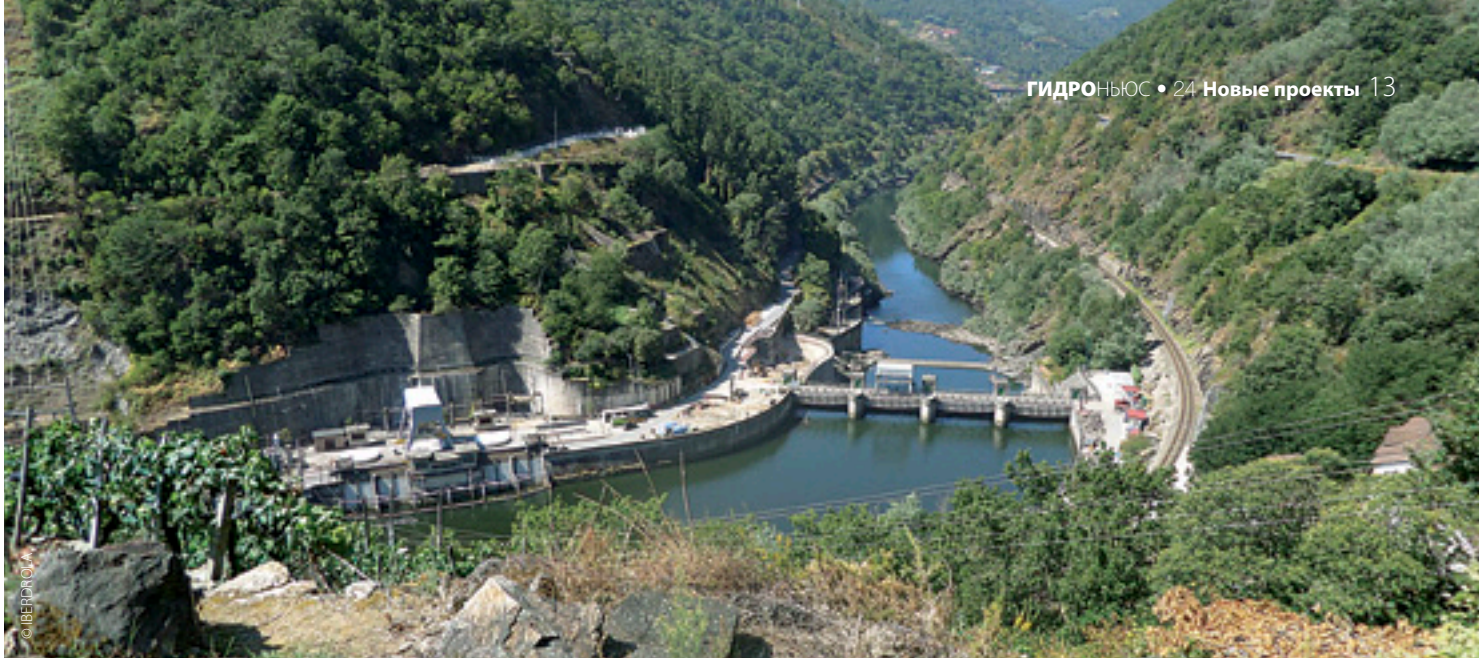
▲ Вид на ГЭС «San Pedro II» со стороны верхнего бьефа
