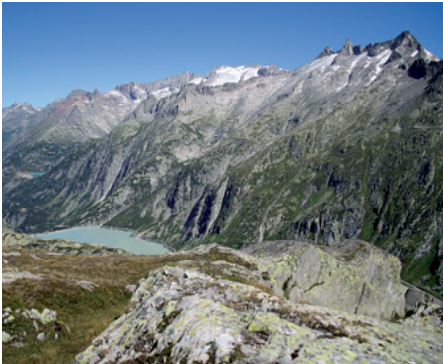
▲ Вид ГЭС «Innertkirchen» и «Handeck» на озере Петерихсбоден
