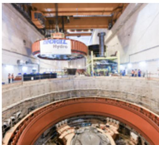
L'installation du rotor de l'alternateur dans son puits nécessite une précision absolue et un grand savoir-faire.
