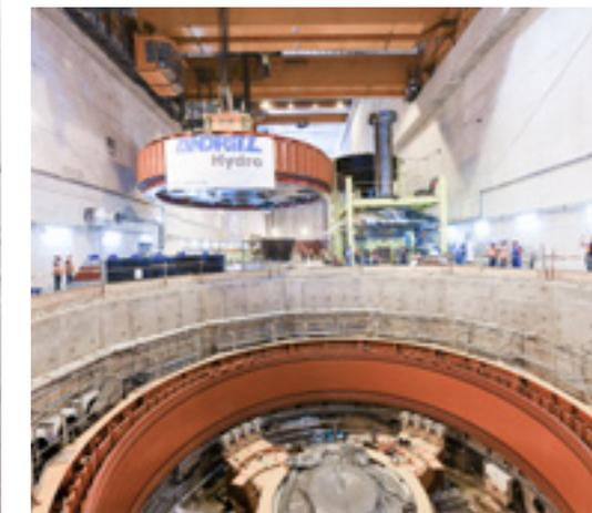
A instalação do rotor do gerador no poço requer precisão absoluta e know-how.
