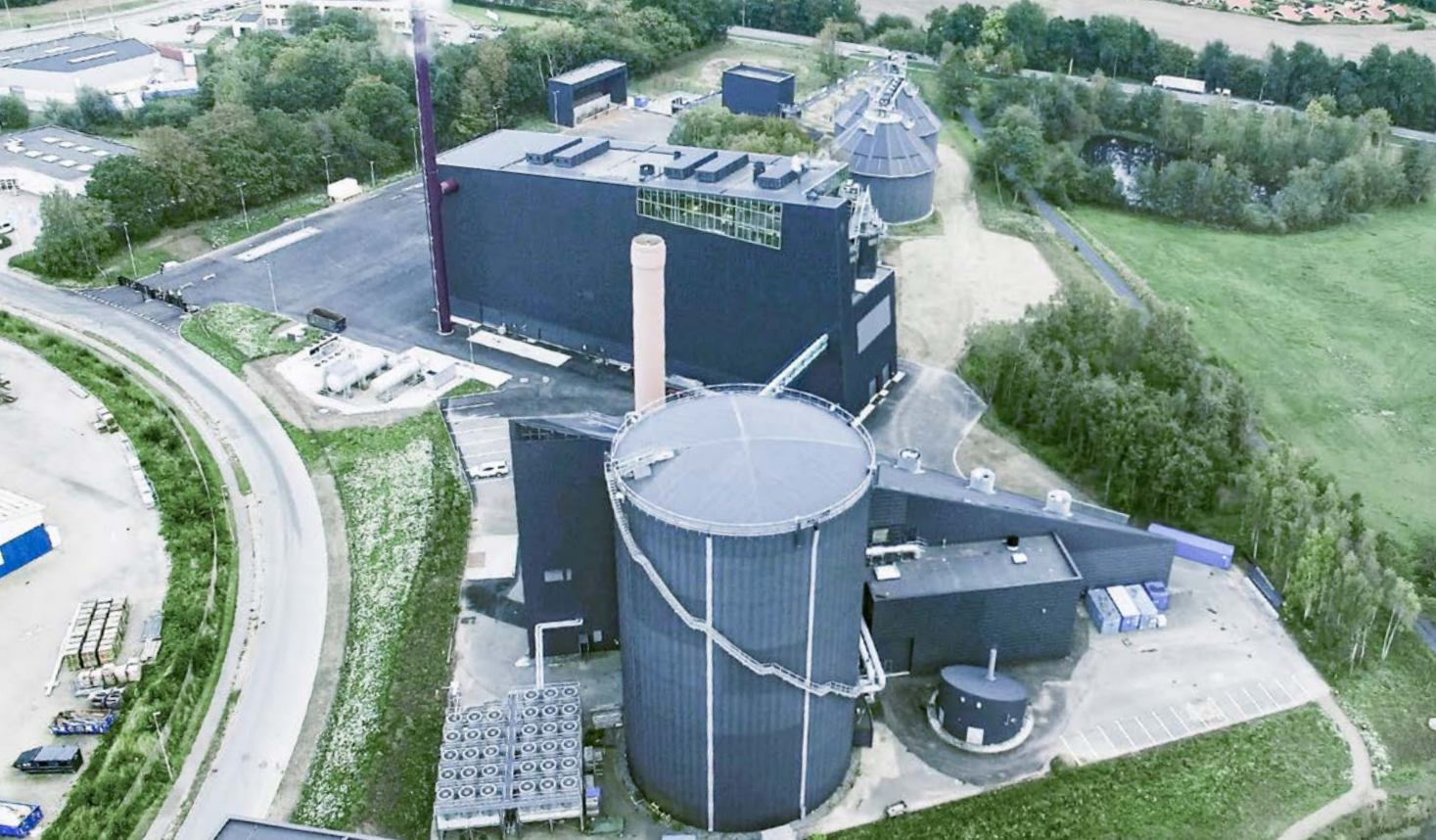
安德里茨的供货范围包括从燃料仓到锅炉出口的锅炉岛，基于鼓泡流化床锅炉Ecofluid设计。
