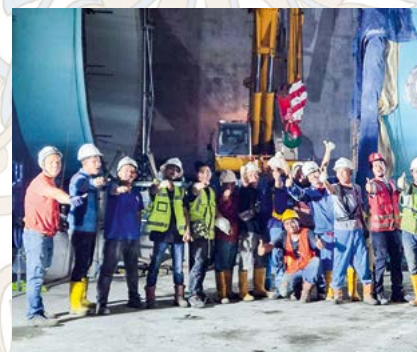
Equipe de instalação da válvula de isolamento de conduto forçado (PIV)
