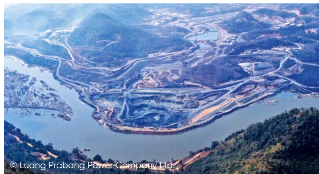
Visão geral do canteiro de obras de Luang Prabang
