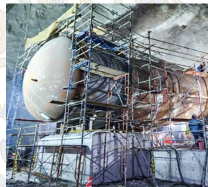
No início de 2023, o teste de pressão para o bifurcador de Asahan 3 foi executado com sucesso.
