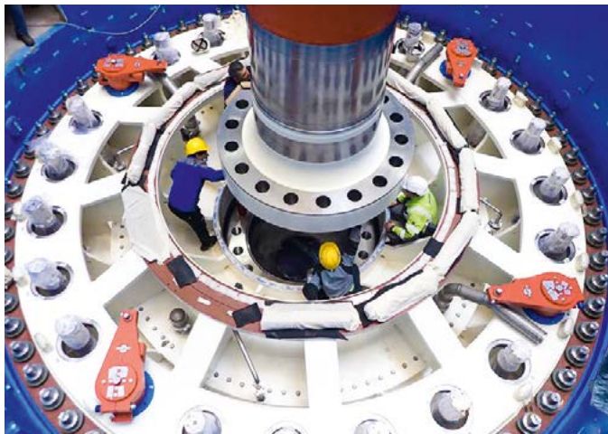
Instalação do eixo da turbina e do aparelho de guia na Unidade A-1
