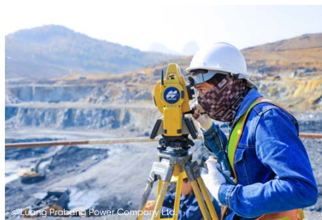
Trabalho de pesquisa na margem do rio no início da construção civil
