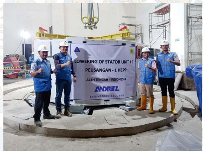
Rebaixamento do estator da Unidade 1 de Peusangan 1
