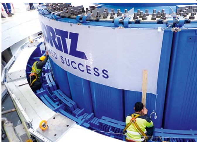
Instalação do rotor do gerador no poço da Unidade A-1
